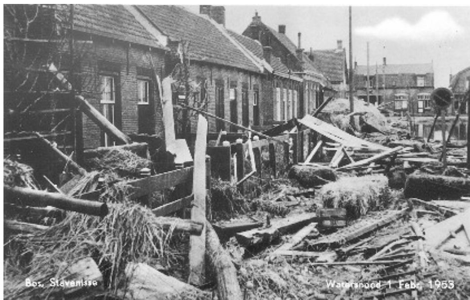
Stavenisse in Zeeland, op 1 februari 1953, na de watersnoodramp.
